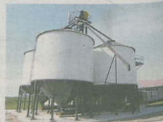
Linie technologiczne magazynów zbożowych
