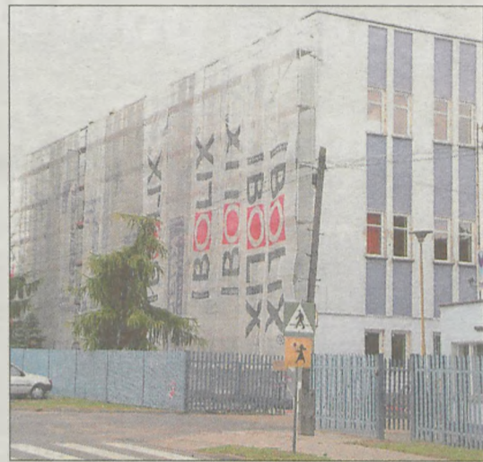
PONAD 700 TYS. ZŁ będzie kosztowała termomodernizacja budynku przy ul. Szubianki. Roboty już się rozpoczęły
