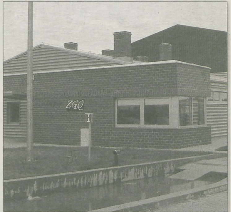
PIERWSZY ETAP CENTRUM GOSPODARKI ODPADAMI - hala z linią do segregacji śmieci i budynek administracyjny zostały oddane do użytku w kwietniu
