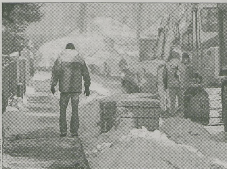
Mróż sparaliżował prace drogowe
