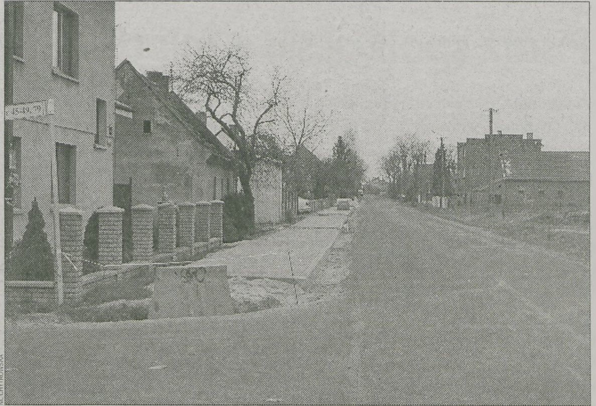
Prace remontowe przy trasie Koźmin Wlkp. – Stara Obrza
