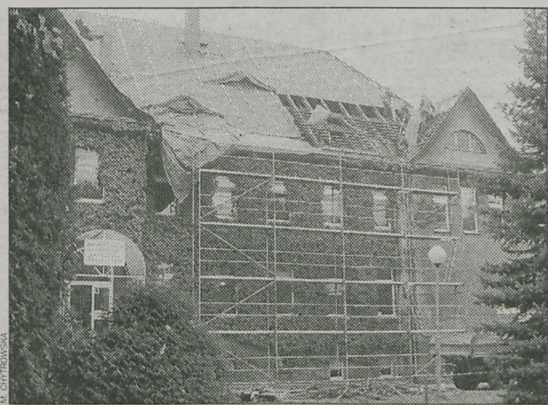
Prace remontowe na budynku szpitala ruszyły pełną parą
