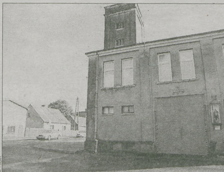
W tym roku zostaną wykonane fundamenty pod część dobudowywaną do świetlicy
