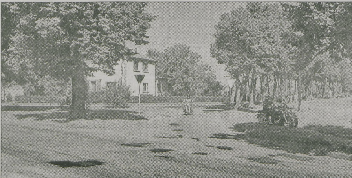
Niezależnie od tragedii na zlocie to skrzyżowanie i tak wymaga modernizacji
