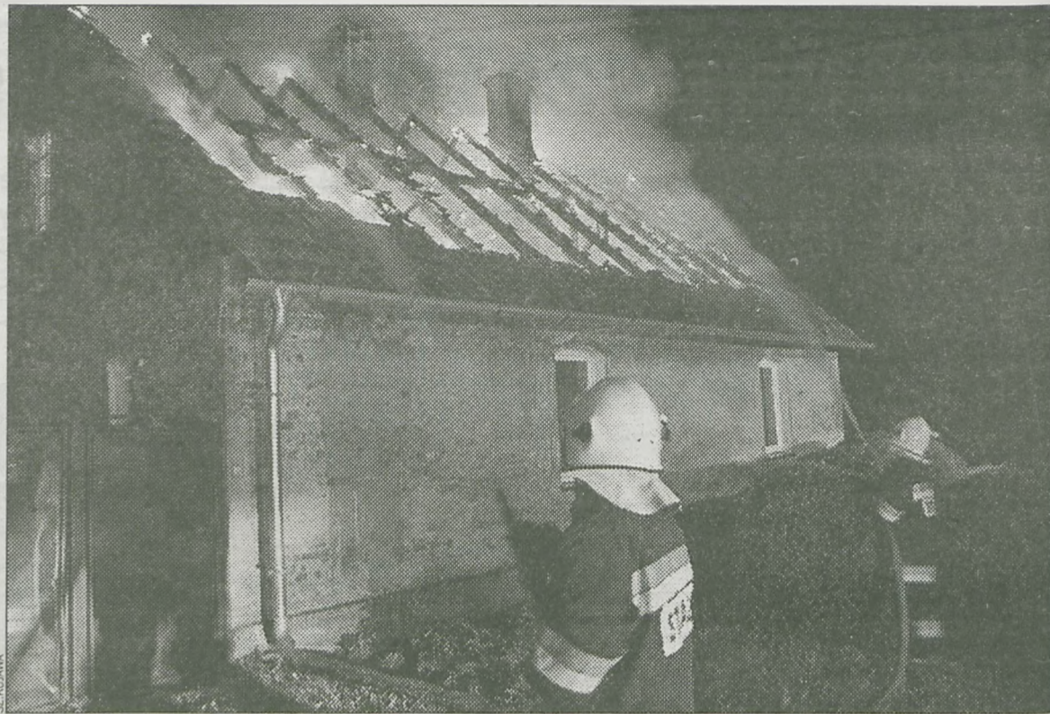
Dach budynku spłonął bardzo szybko
