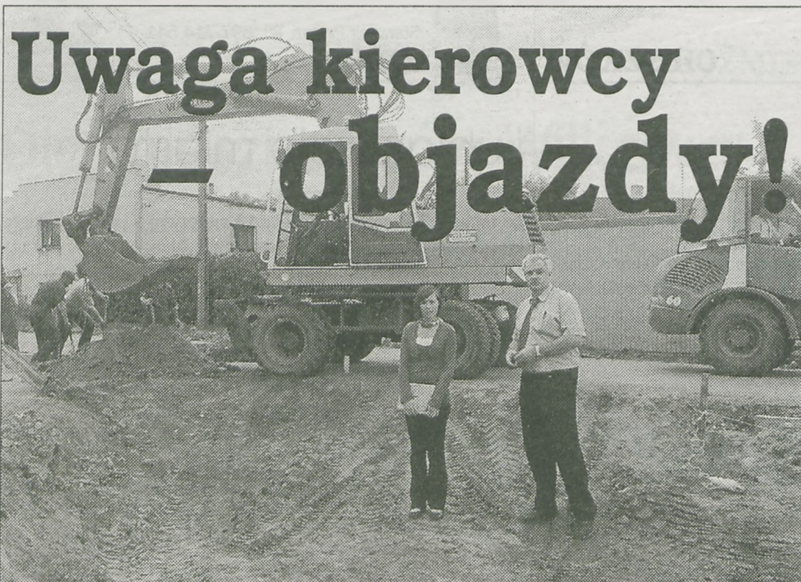
Trwają już prace na Szosie Benickiej
