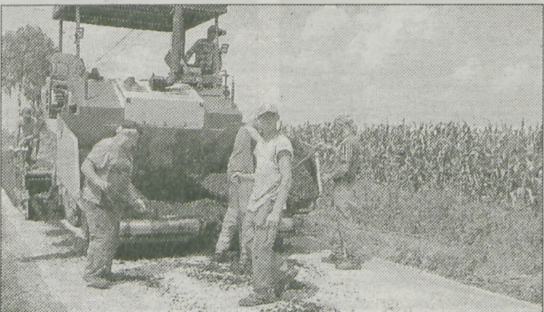
Jako pierwsze rozpoczęły się prace drogowe w Nowej Wsi
