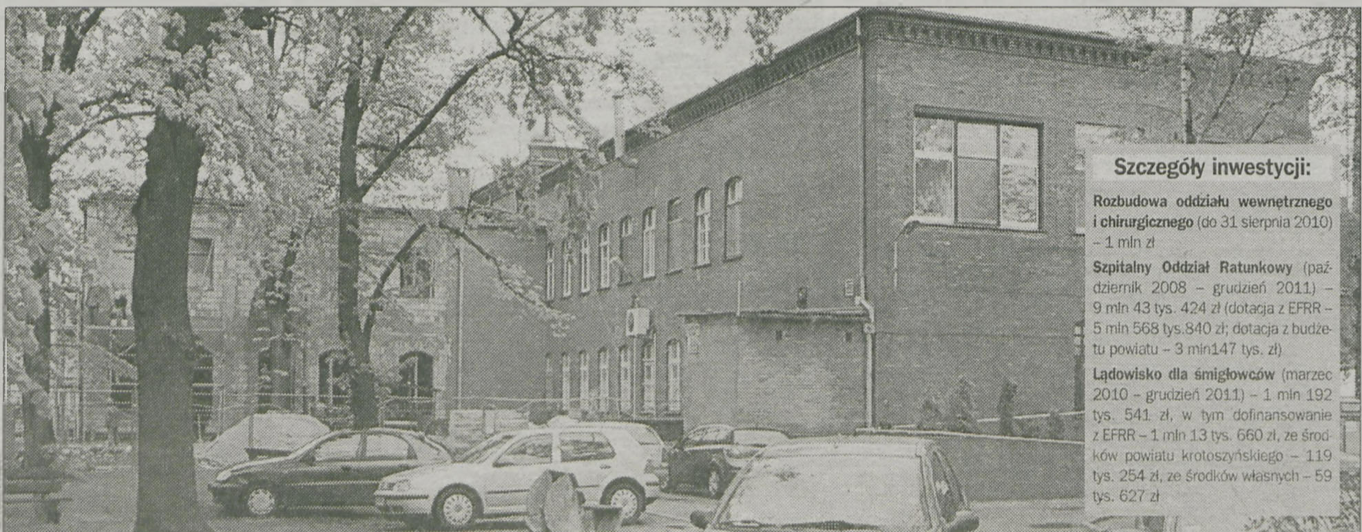
Trwa rozbudowa oddziału wewnętrznego i chirurgicznego przy ul. Mickiewicza
