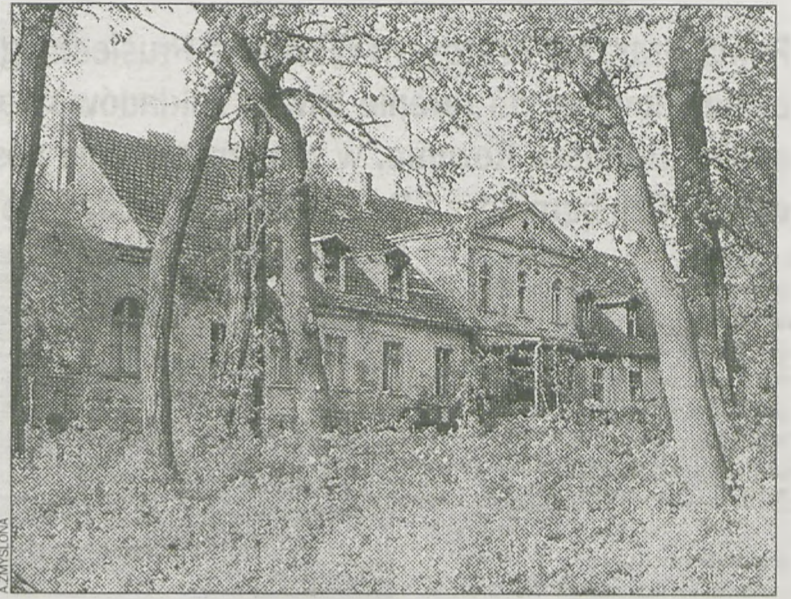
Zdewastowany dwór ma zostać przekształcony w gospodarstwo agroturystyczne
