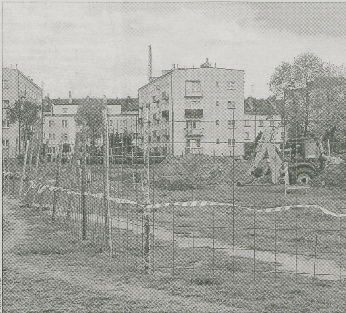
Inwestor uzyskał pozwolenie na budowę magazynów szkła
