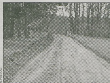
Droga została wyrównana
