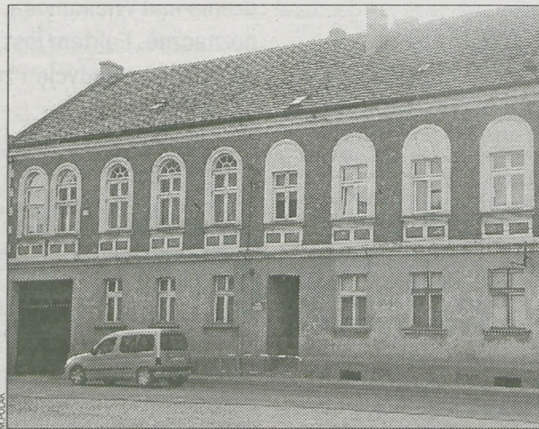
W tym budynku znajdują się lokale mieszkalne i Klub Seniora
