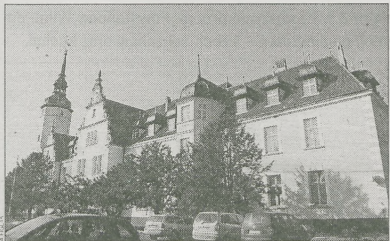
Z daleka nie widać uszkodzeń dachu
