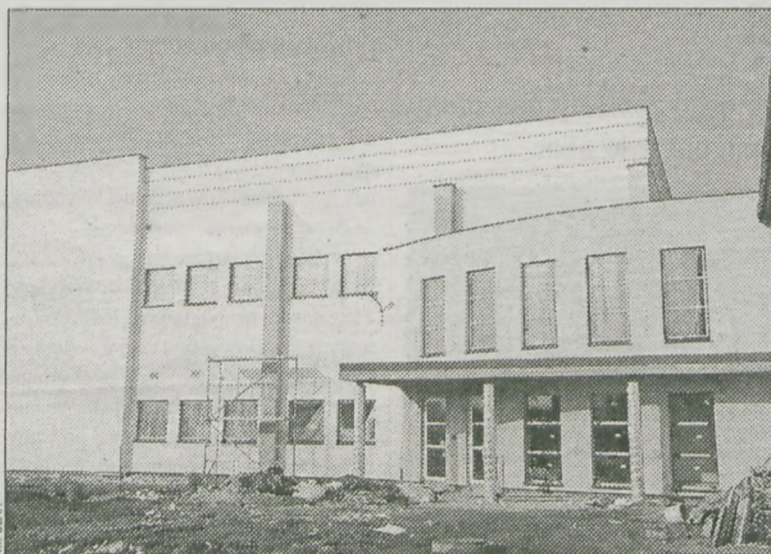
Pozostały jeszcze prace wykończeniowe, elewacyjne i zagospodarowanie terenu
