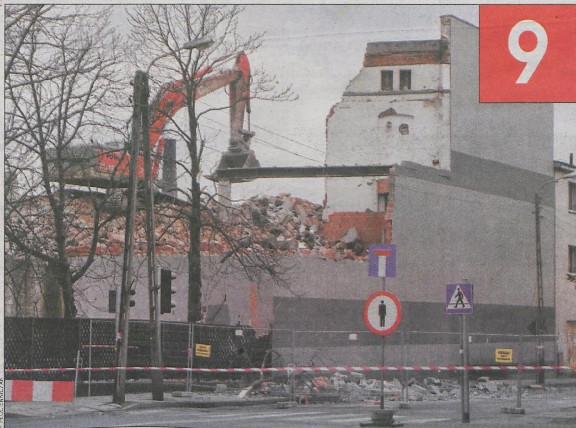
W sobotę przystąpiono do rozbiórki ściany przy ul. Kobylińskiej
