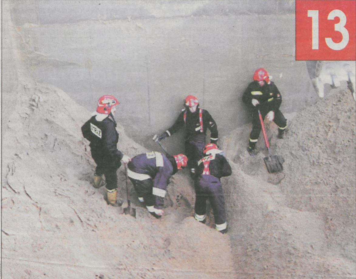
Piasek przekopywano łopatami i koparką
