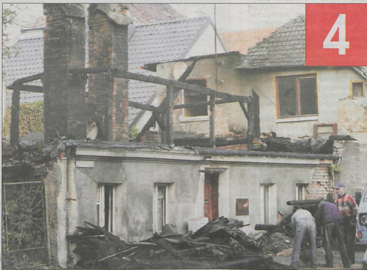
W ostatni poniedziałek rozbierano spaloną drewnianą konstrukcję
