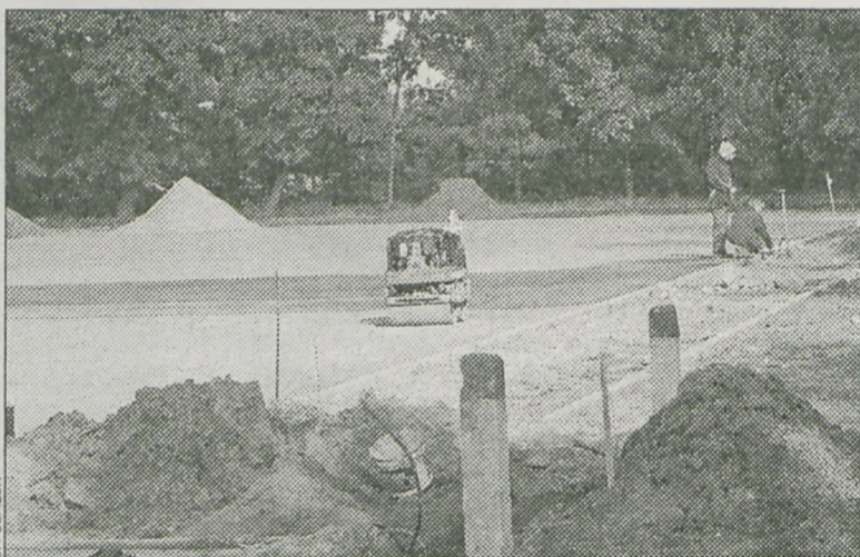
Budowa orlika w „kołłątaju” pochłonie nieco ponad 1 mln zł
