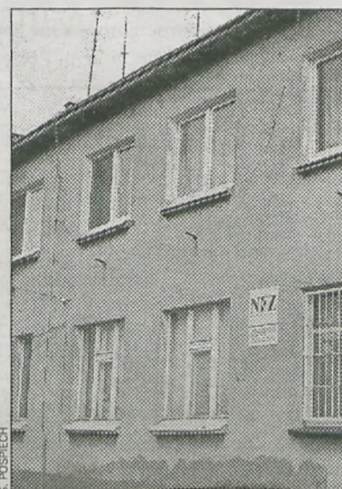
W przychodni wstawione będą nowe okna
