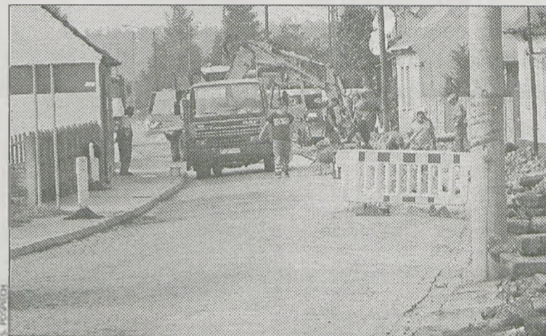
W poniedziałek droga była już przejezdna
