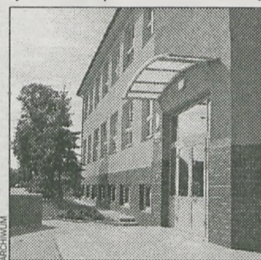
Już wkrótce zostanie wymieniony dach
