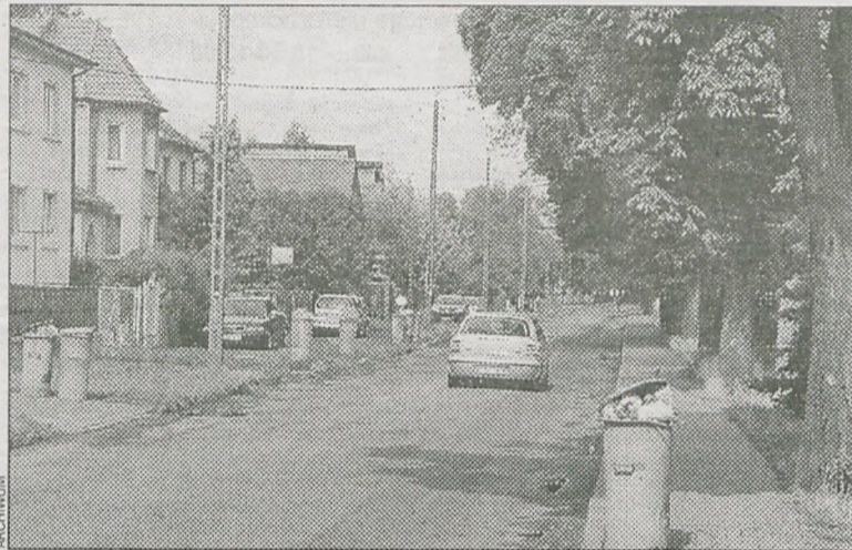
Nawierzchnia ul. Staszica zostanie wyremontowana
