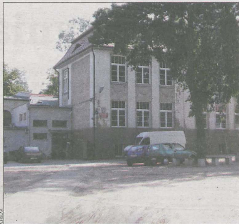
W Szkole Podstawowej nr 4 prace remontowe trwały do ostatniej chwili
