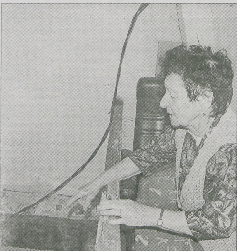
Pani Maria pokazuje wiszący kabel – fragment prowizorycznej instalacji elektrycznej w jej mieszkaniu
