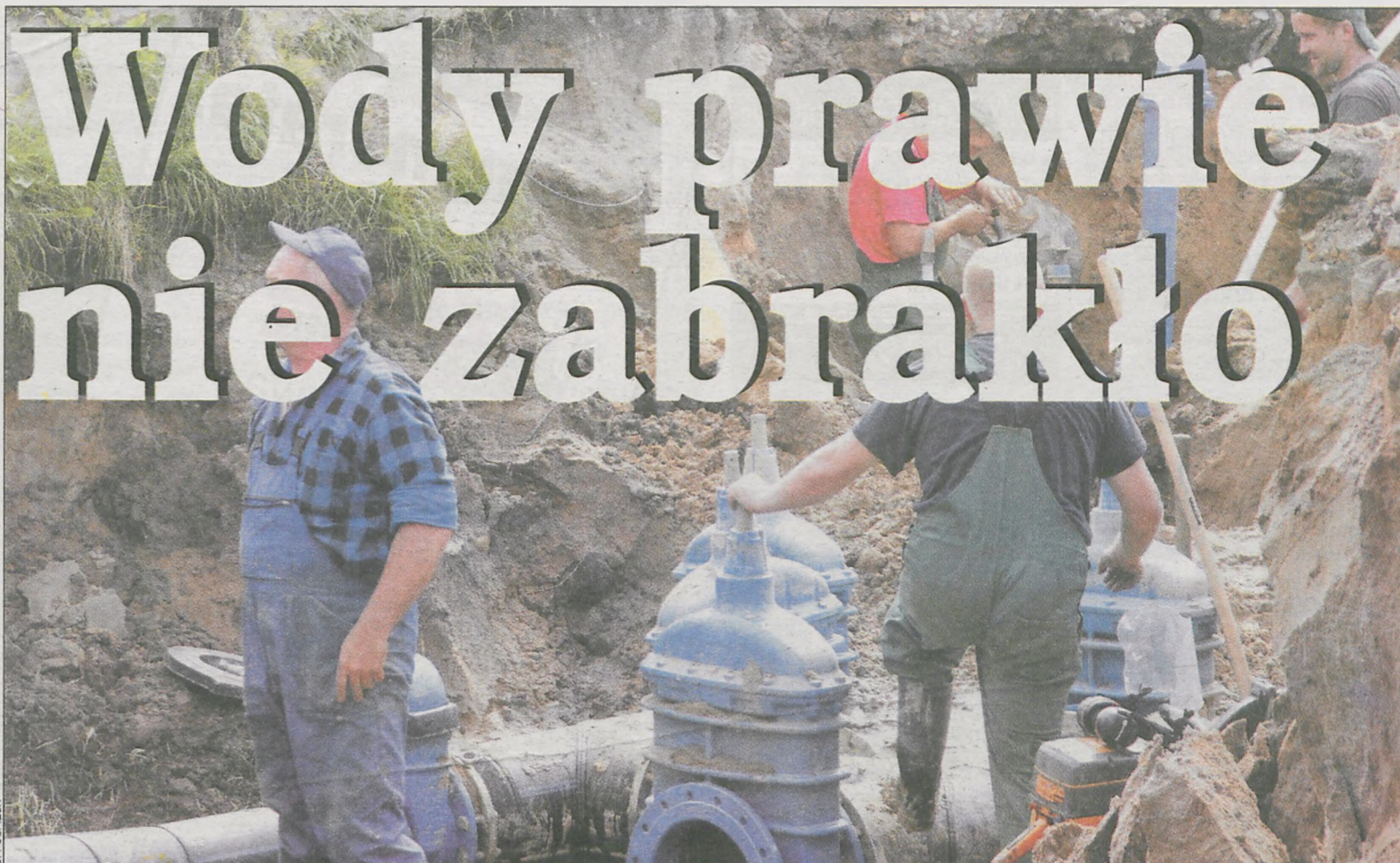
Przełączanie rurociągu przy ul. Gajowej
