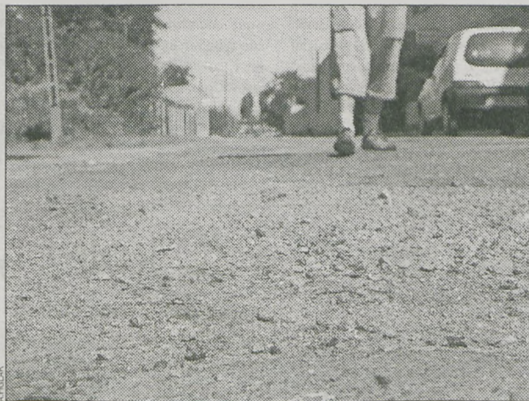
Dziury zalano asfaltem i zasypano grysem
