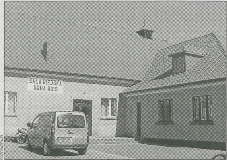
Dach świetlicy w Nowej Wsi został zupełnie wymieniony
