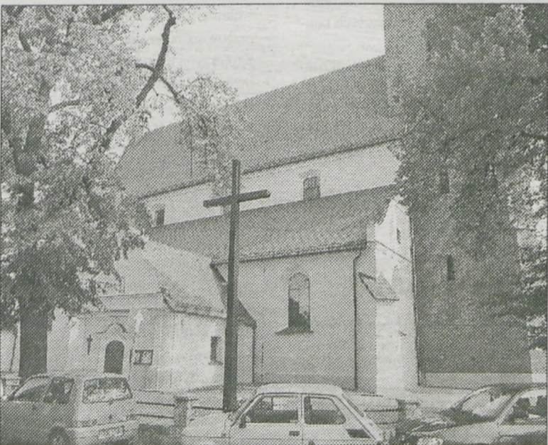
Niebawem ruszą kolejne prace remontowe
