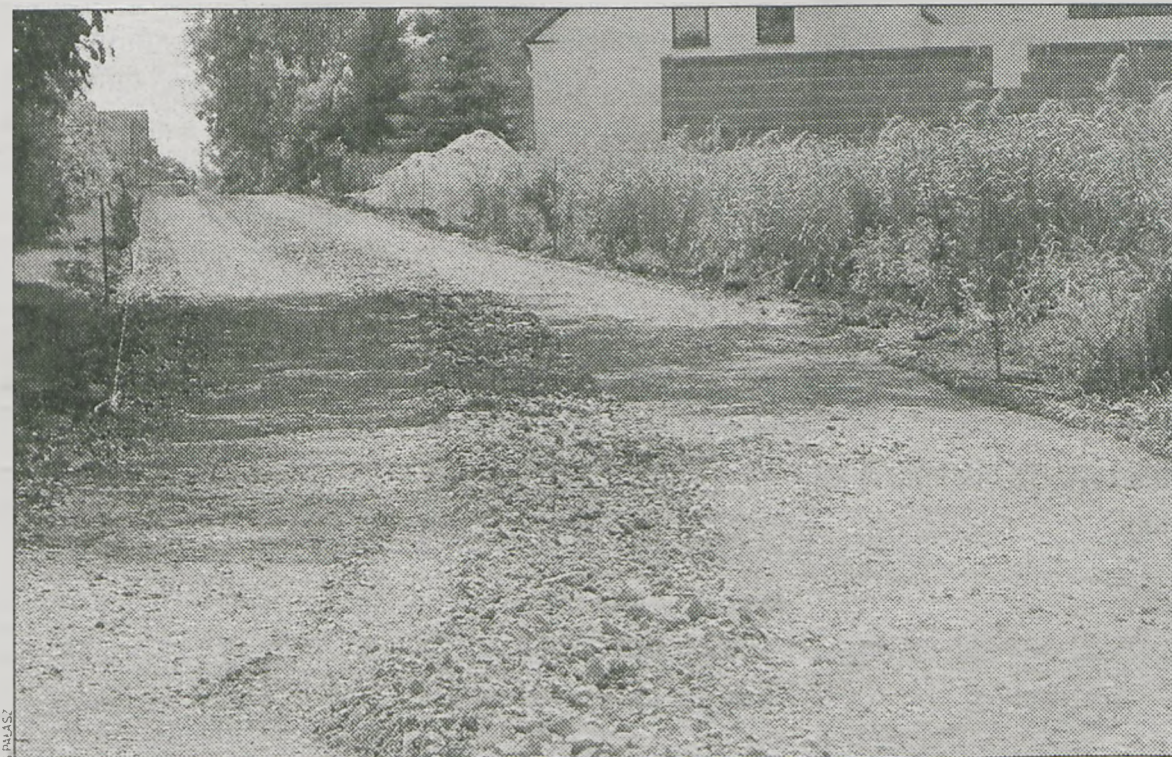
Droga w Baszkowie została już wyremontowana
