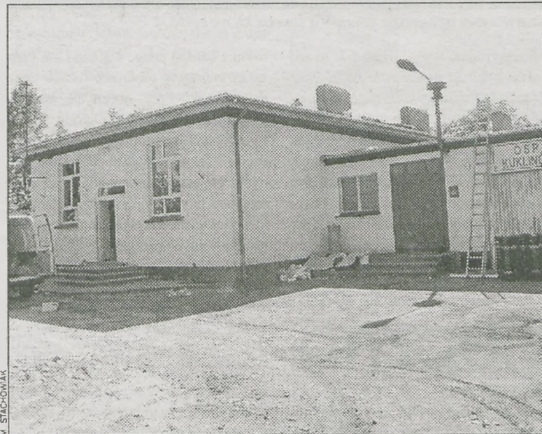
Obecne prace to m.in. pokrycie dachu papą
