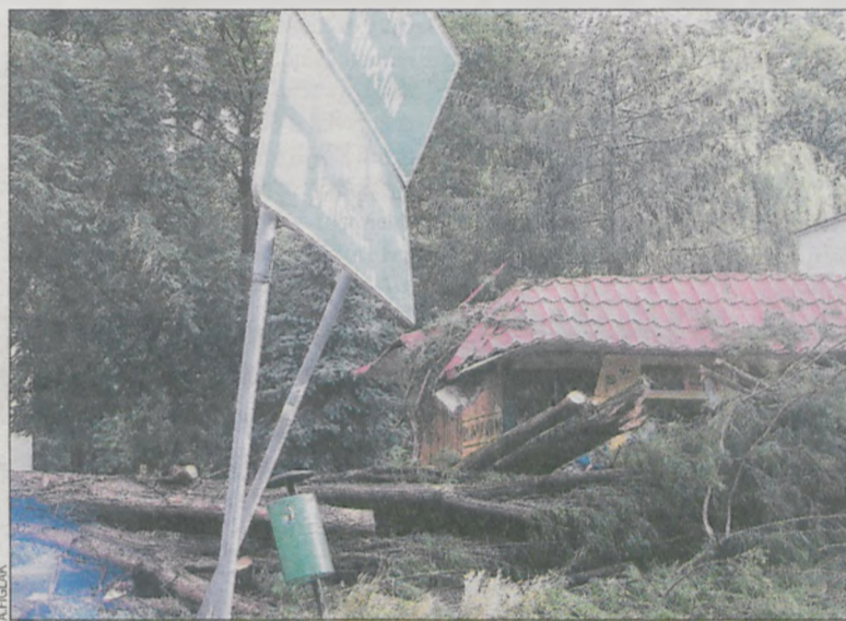
Na Piastowskiej spadające drzewa uszkodziły dach kiosku
