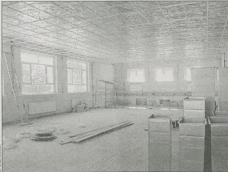
Sala jest już częściowo wyremontowana
