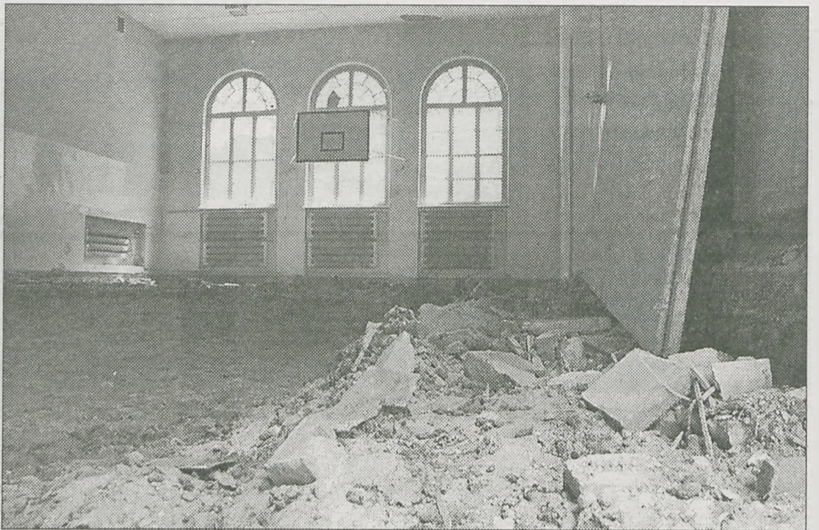
W sali gimnastycznej będzie nowy parkiet, okna i grzejniki
