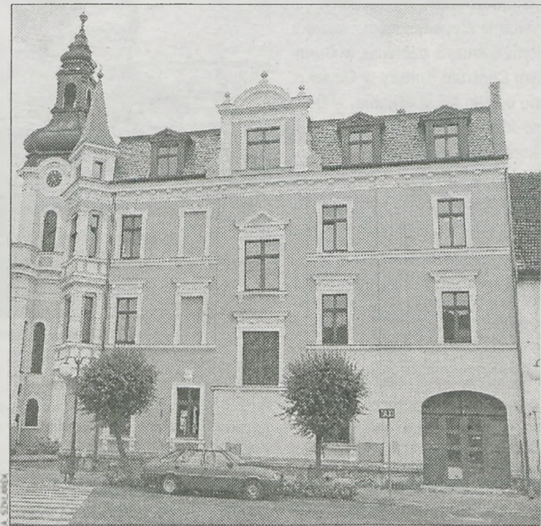
Dziś odrestaurowany budynek przyciąga wzrok wielu osób
