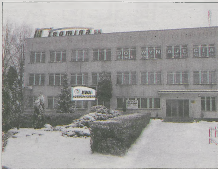
Firma znajduje się w budynku „Teomina” przy ul. Ceglarskiej
