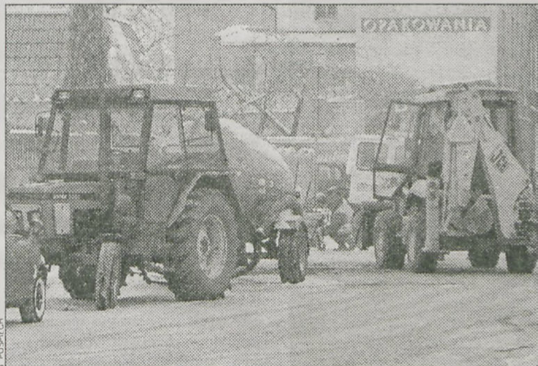
Usuwanie pęknięcia rury trwało kilka godzin
