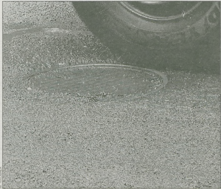
Studzienkę doraźnie zabezpieczono
