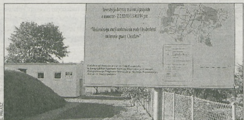
W ubiegłym roku zakończono modernizację tej hydroforni
