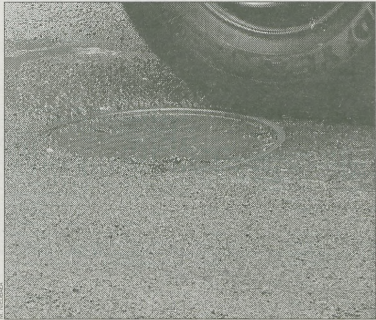
Studzienkę doraźnie zabezpieczono
