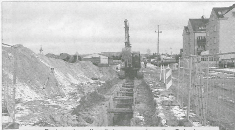
Budowa kanalizacji deszczowej w ulicy Polnej
