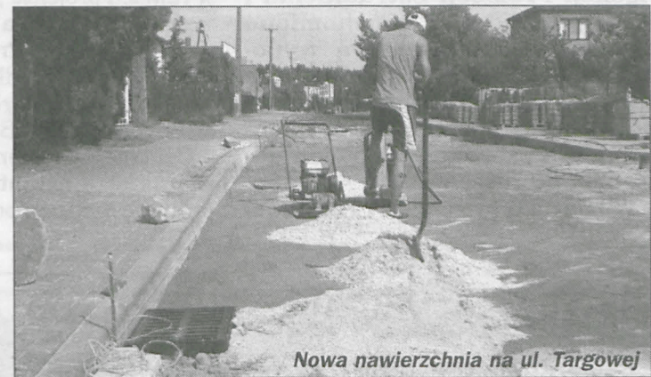
Budowa chodnika w Rogalinku
