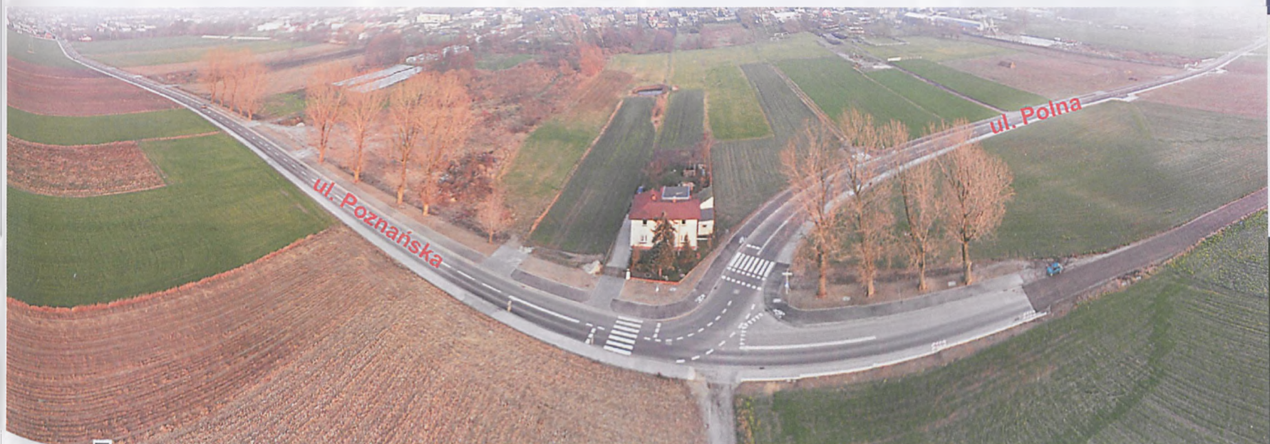
Panorama obwodnicy z lotu ptaka. Z tego miejsca widać potencjał terenów przy ciągu ulic: Poznańskiej – Polnej. Na pierwszym planie z prawej widać urwane utwardzenie ul. Poznańskiej prowadzącej bezpośrednio na cmentarz w Wirach. Na horyzoncie – zabudowania przy ul. Sobieskiego fot. Rafał Wojtyński
