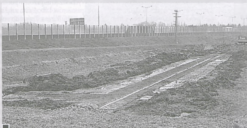
Modernizacja zbiornika przy ul. Unijnej fot. Jan Błaszczak
