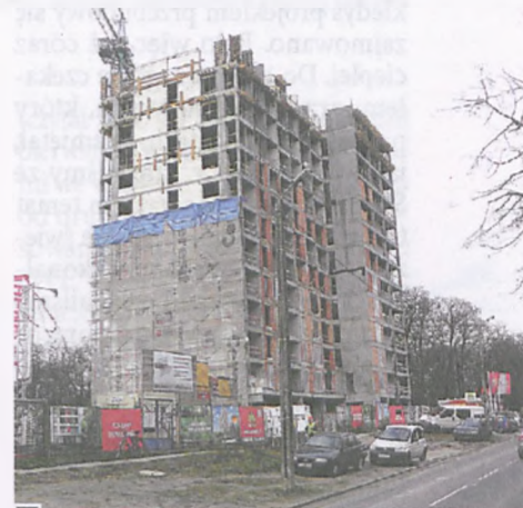
Pierwszy z czterech 13-piętrowych budynków mieszkalnych osiedla RED Park, w których do końca przyszłego roku, w sześciuset lokalach zamieszka około 2 tys. osób fot. Paweł Wolniewicz
