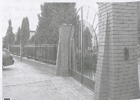
Nowe ogrodzenie żabikowskiej nekropolii z klinierowymi słupkami i fundamentem oraz kutymi w metalu przęsłami i bramą. Podmurówkę wykończono kamiennymi płytami fot. Hanna Siatka
