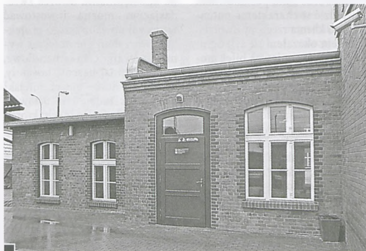
Zamknięta od czasu zakończenia remontu poczekalnia z kasą biletową i toaletami dla podróżnych fot. Katarzyna Polerowicz-Kelma
