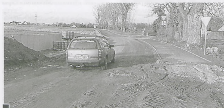
Po pokonaniu 470 m gruntowej ul. Poznańskiej w Luboniu wjeżdżamy na nowo wybudowaną obwodnicę przy skrzyżowaniu z ul. Polną fot. Paweł Wolniewicz
