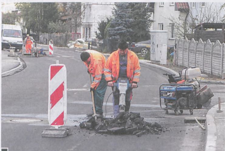
Przygotowania i osadzanie włazów studzienek kanalizacyjnych na ul. Połej fot. Mariusz Marszałkiewicz
