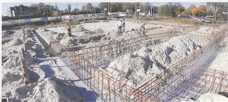
Wylewanie fundamentów pod pierwszy obiekt hotelowy. Wystające zbrojenia pokazują wielkości każdego mieszkania. Piotr P. Ruskowski
