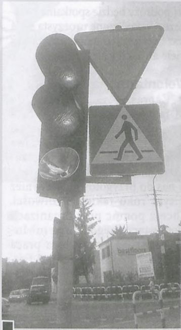
Uszkodzona sygnalizacja świetlna na skrzyżowaniu ul. Armii Poznań i Dąbrowskiego, przy Gimnazjum nr 1 i SP 3 fot. Leszek Tomaszuk
