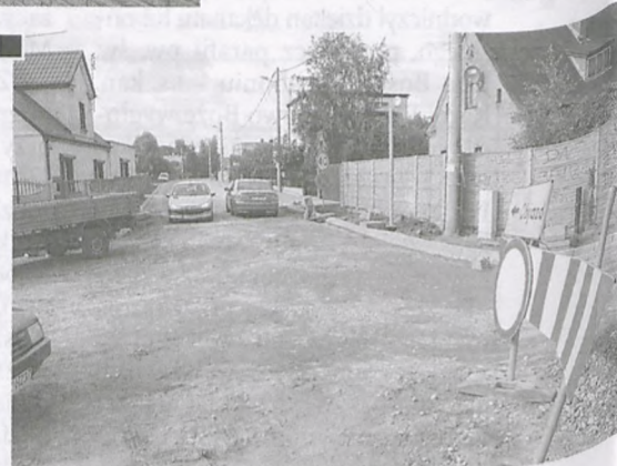
Na ul. Krętej przygotowuje się krawężniki i podbudowę pod asfalt fot. Piotr P. Ruskowski
