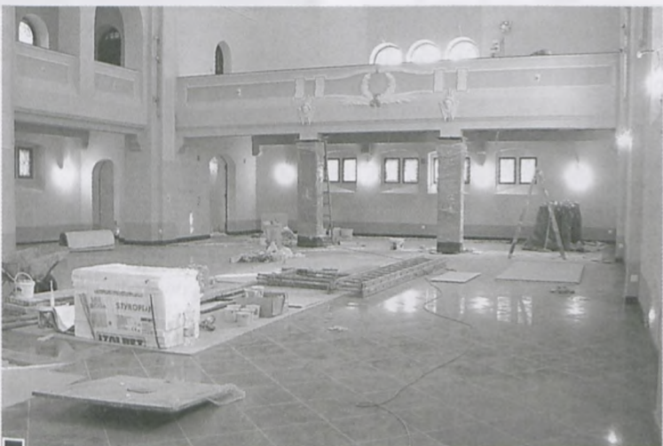
Stan świątyni z 4 września. Płytkarze kończyli prace, trwało układanie posadzki przy ołtarzu fot. Hanna Siatka
