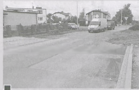
Wlot ul. Poznańskiej w Buczka, przy którym nic się nie dzieje. Brakuje wytyczonego profilu jezdni, krawężników, fragmentów chodnika itd. fot. Piotr P. Ruszkowski
