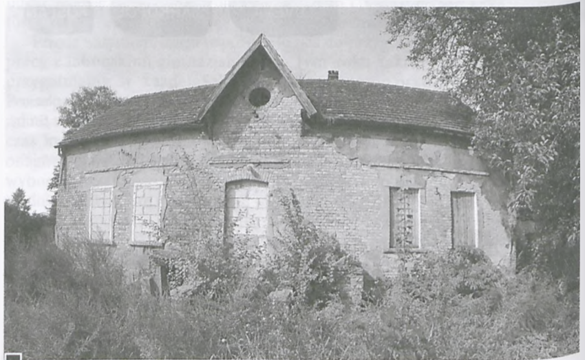
Jedna z ciekawszych pozostałości po historycznym folwarku hr. Augusta Cieszkowskiego – Dom Włodarza przy ul. Puszkina. Do niedawna służył za mieszkanie komunalne. Od kilku lat stoi pusty i niszczeje (stan obecny) fot. Piotr P. Ruszkowski
