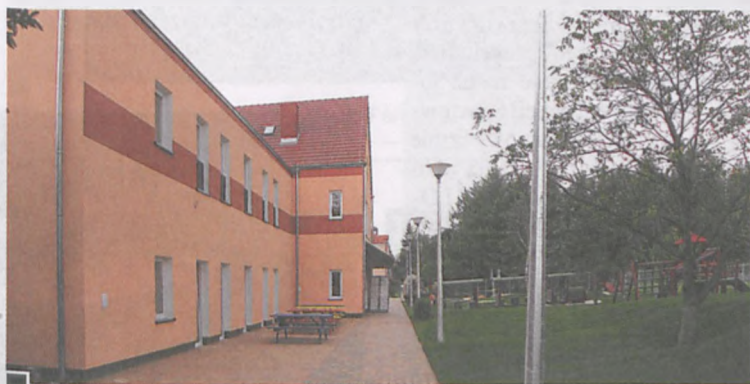
Widok od strony ul. Granicznej. Funkcjonalnie zaplanowany kompleks przedszkolny jest wyposażony w niezależne wejście, ekologiczny plac zabaw i miejsce, gdzie maluchy mogą odpocząć oraz posilić się na powietrzu (patrz: rząd stołów i ławek przed budynkiem). Przez duże okna na przyziemiu rodzice mogą obserwować bawiące się w salach pociechy fot. Hanna Siatka
