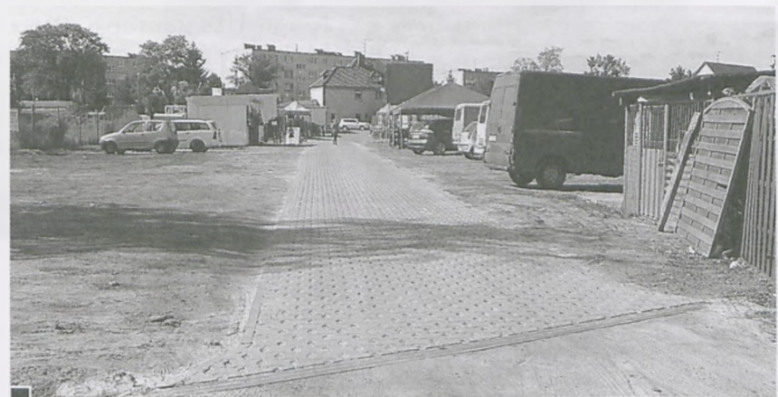
Utwardzona ekokostką droga ułatwia dojazd i dojeżdżanie do parkingów oraz pawilonów i stoisk fot. Paweł Wolniewicz
