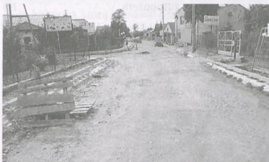
Na ul. Krętej przygotowuje się krawężniki i podbudowę pod asfalt fot. Piotr P. Ruskowski
