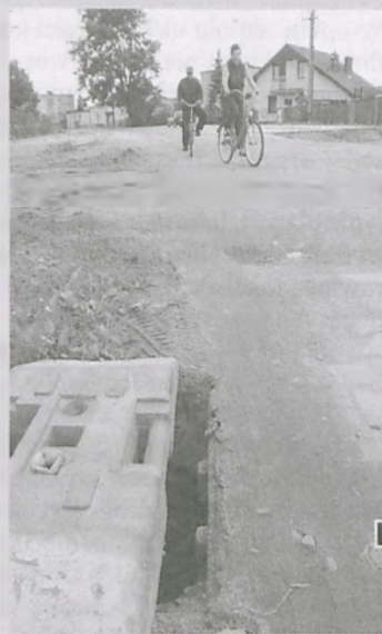
Słabo zabezpieczony wlot studzienki kanalizacji deszczowej, szczególnie niebezpieczny dla rowerzystów fot. Piotr P. Ruszkowski
