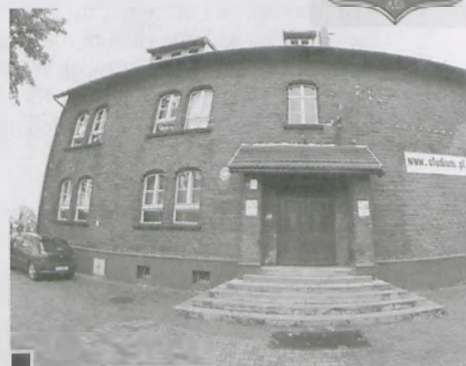
Budynek zabytkowej lubońskiej szkoły przy ul. Armii Poznań fot. Piotr P. Ruszkowski
