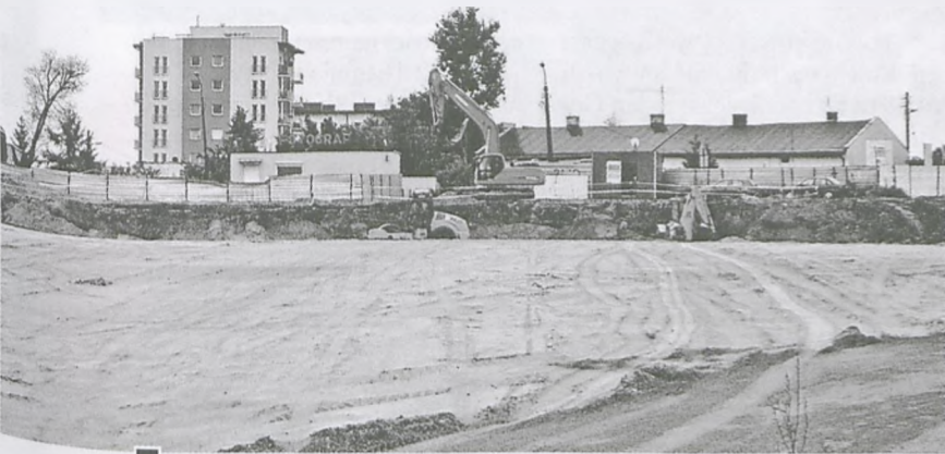
Zasypywany i wyrównywany nadal teren pod przyszłe Intermarche fot. Katarzyna Kelma
