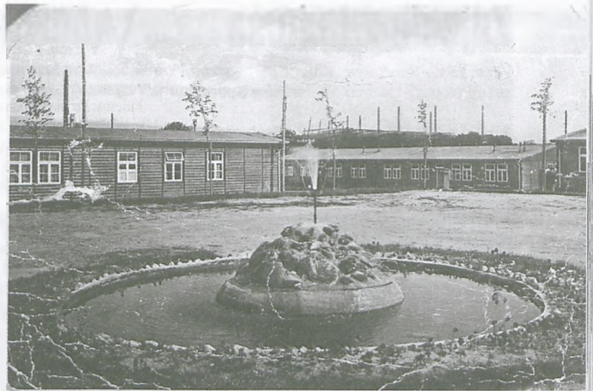
17. - Gemeinschaftslager Wilhelmshof / Brandenburg (Havel) - Telefon 2006
