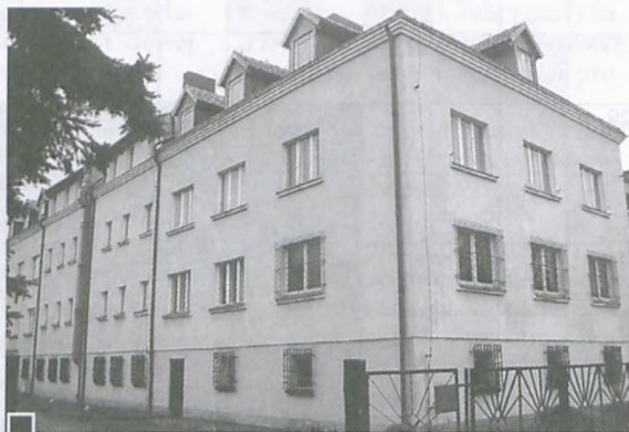
Budynek Zgromadzenia Sióstr Służebniczek – widok od ul. Zielonej fot. Jan Błaszczak
