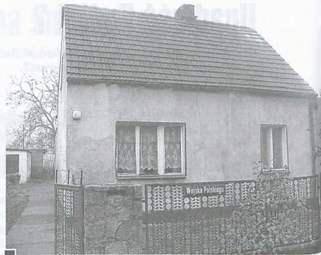
Zakupiona przez Wspólną Drogę przy ul. Wojska Polskiego 42 posesja z domkiem, prawdopodobnie do rozbiórki, gdzie docelowo będzie ośrodek dziennego pobytu dla osób niepełnosprawnych
