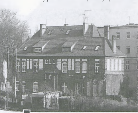
Jeden z budynków Spójni, który po remoncie dachu wzbogacił się o nowe mieszkania fot. Piotr P. Ruszkowski
