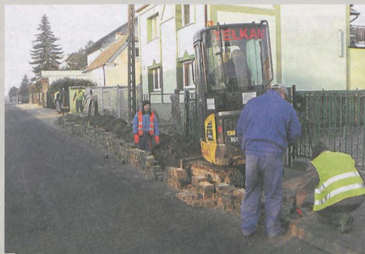
Układanie kabla światłowodowego w chodniku ul. Pułaskiego stanowiącej odcinek połączenia wieży na ul. Żabikowskiej z wieżą zlokalizowaną przy ul. Przemysłowej fot. Paweł Wolniewicz
