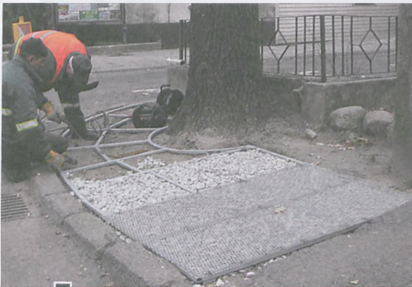
Podczas spawania konstrukcji umacniającej chodnik w piątek, 18 listopada fot. Hanna Siatka
