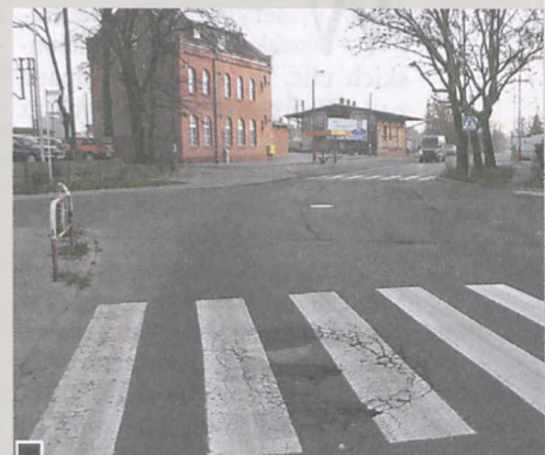
Oto przykłady ulic wymagających interwencji – załomy, spękania i dziury na przejściu dla pieszych na ul. ks. Streicha, przy wlocie w ul. Dworcową fot. Paweł Wolniewicz
