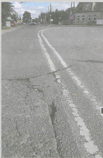
Oto przykłady ulic wymagających interwencji – załomy, spękania i dziury na przejściu dla pieszych na ul. ks. Streicha, przy wlocie w ul. Dworcową fot. Paweł Wolniewicz
