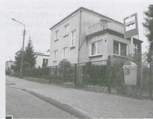
Pozbawiony zadaszenia po remoncie drogi przystanek przy ul. Fabrycznej fot. Piotr P. Ruszkowski
