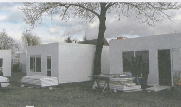
Trwa montaż pawilonów na ścianie wschodniej fot. Paweł Wolniewicz
