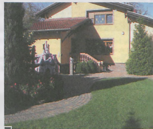
Widok przedszkola Calineczka z nowym oddziałem żłobka od strony ogrodu
