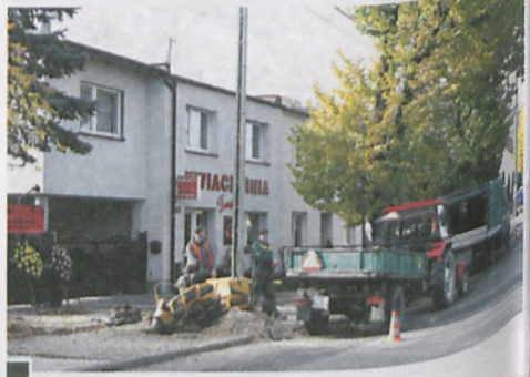
Frezowanie korzenia po wyciętej lipie na ul. Wojska Polskiego
