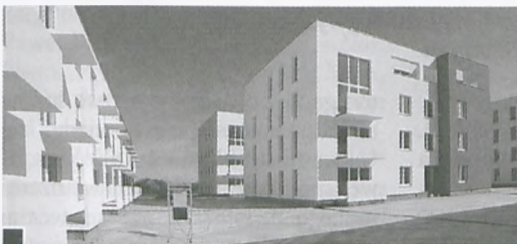
Pierwsze bloki czekają na swoich mieszkańców. Pomiedzy budynkami na betonowe płyty – strop podziemnego parkingu – zostanie nałożone kilkadziesiąt cm ziemi i trawa fot. Piotr P. Ruskowski
