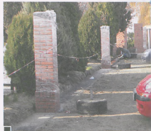
Fundamenty i klinkierowe filary nowego płotu przy bramie głównej na ul. Cmentarnej fot. Hanna Siatka
