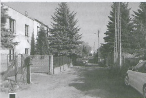
Ulica Żytnia – problem nieuregulowanych własności gruntów pod drogi przeszkadza w budowie kanalizacji fot. Piotr P. Ruskowski
