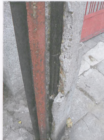
Uszkodzona podstawa słupa energetycznego na ul. Dożynkowej fot. Paweł Wolniewicz
