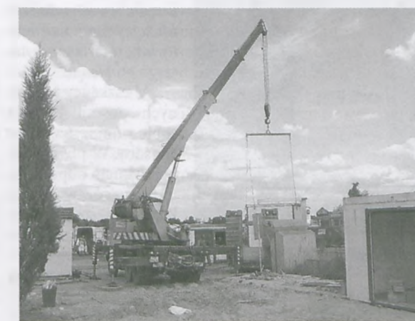
Stojące tu przez wiele lat pawilony handlowe zostały przy użyciu dźwigu załadowane na specjalnie do tego celu przystosowany samochód ciężarowy i przewiezione na swoje nowe miejsce fot. Paweł Wolniewicz
