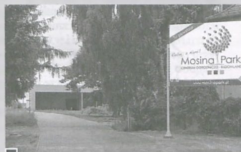
Wjazd na plac budowy Centrum Ogrodniczo-Budowlanego Mosina Park fot. Katarzyna Kelma
