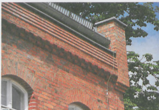
Pieczołowicie odnowiono szczegóły architektury. Uwypukliły się przez to ciekawe zdobienia gzymsu i łuki okienne fot. Piotr P. Ruszkowski
