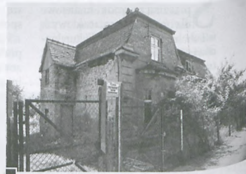
Zabezpieczony przed bezdomnymi niezamieszkały poniemiecki dom przy ul. Poniatowskiego fot. Katarzyna Polerowicz-Kelma
