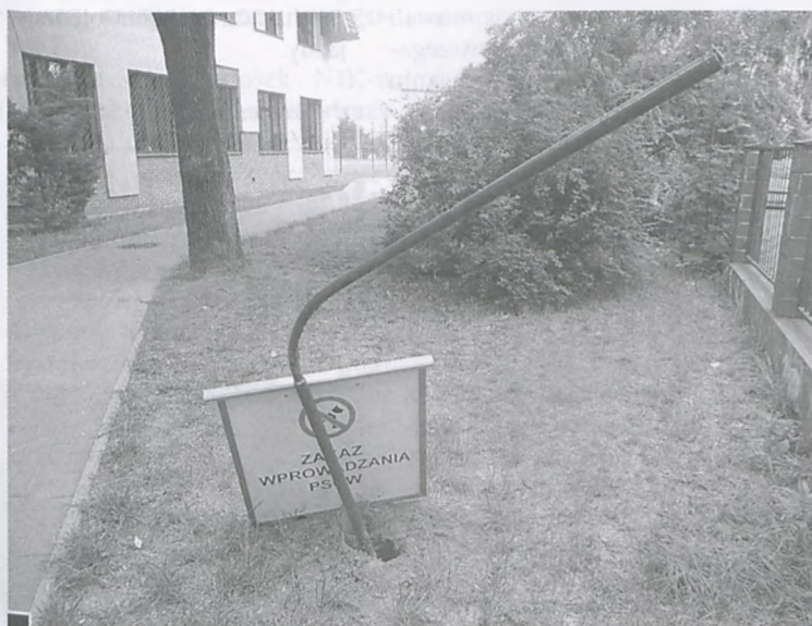
Zniszczony, wygięty słup i zerwana tablica przy wejściu na boisko. Miejmy nadzieję, że sprawcę zarejestrował monitor fot. Władysław Szczepaniak
