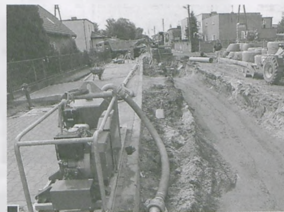
Na ul. Poznańskiej specjalna pompa wytwarzająca podciśnienie do 10 atmosfer ściąga podczas budowy kanalizacji deszczowej wody gruntowe fot. Piotr P. Ruszkowski
