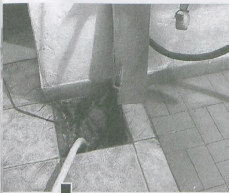
W piwnicach po wykuciu odpowiednich otworów ściągających wodę umieszcza się pompy fot. Paweł Wolniewicz
