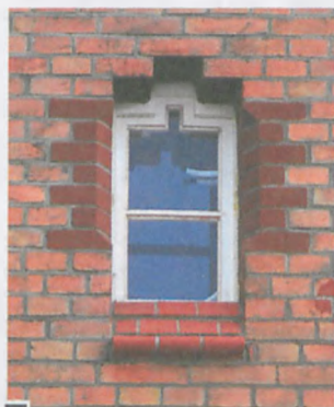
Precyzyjnie do historycznych otworów dobrano okna. Odkryto pierwotne kolorystycznie odmienne wykończenia otworów okiennych fot. Piotr P. Ruszkowski
