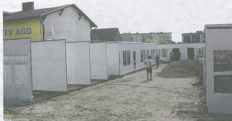
Również w miejscu dawnego placu do nauki jazdy (okolice sklepu Skrzat ) trwają prace montażowe. Ustawia się tu jednakowe pawilony. W tym miejscu handel jeszcze nie funkcjonuje fot. Paweł Wolniewicz
