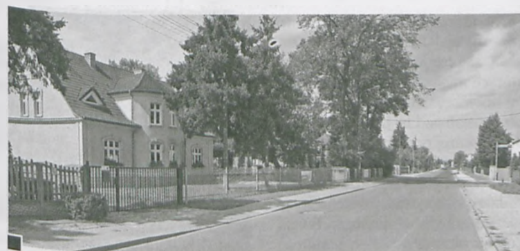
Brak pasów na jezdni przy publicznej placówce – Przedszkolu Tęczowa Kraina fot. Katarzyna Polerowicz-Kelma
