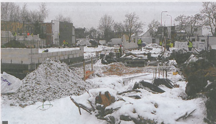
Pomimo mrozów prywatny inwestor buduje, co zaplanował fot. Paweł Wolniewicz
