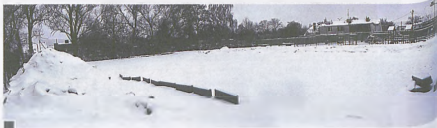
Maszyny zniknęły, śnieg przykrył teren budowy fot. Paweł Wolniewicz
