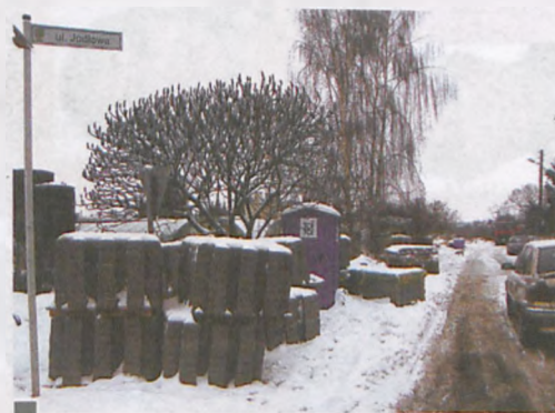
Pobocze ul. Jodłowej zajęte przez materiał budowlany i zaplecze socjalne fot. Hanna Siatka
