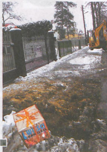
Podczas krótkiej odwilży demontowano stare krawężniki i płyty oraz przygotowano grunt pod wjazdy na posesje fot. Hanna Siatka
