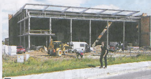
Budowany salon Bemo Motors przy ul. Opłotki 2 fot. Hanna Siatka
