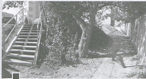
Pomiędzy ogrodzeniem budowy (cień z lewej) a betonowym płotem ROD (z prawej) zainstalowano prowizoryczne schody, a obok (za pasem zieleni wzdłuż płotu) – zjazd fot. Piotr P. Ruszkowski
