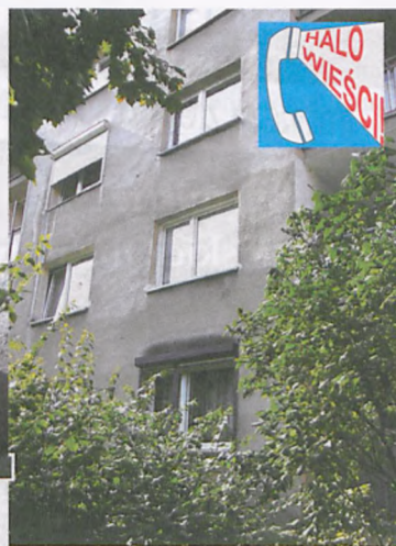
Wyraźnie widoczne zmiany na murze bloku 43 spowodowane zawieszeniem zewnętrznych żaluzji fot. Piotr P. Ruskowski
