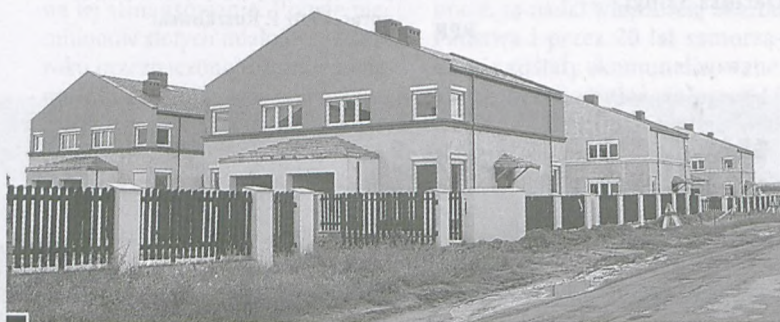
Prawie gotowe domy przy ul. Nowiny fot. Mateusz Tritt
