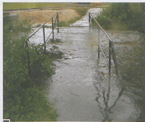
Problemy z wodą mieli też mieszkańcy ul. Strumykowej. Wysokość wody widać na zalanej kładce na Strumieniu Junikowskim prowadzącej do szkoły na ul. Hibnera fot. Paweł Wolniewicz
