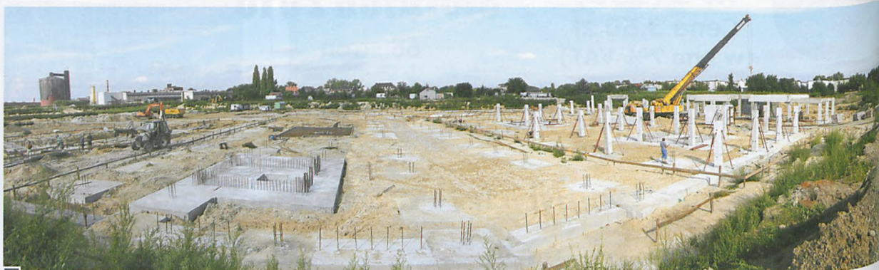
Panorama budowanego osiedla, widok od strony usypanego w maju wału przeciwpowodziowego. Z prawej widać charakterystyczny silos – zbiornik na krochmal i fabrykę domów w zaadaptowanym magazynie Zakładów Ziemniaczanych fot. Piotr P. Ruskowski
