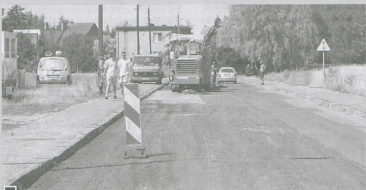
Moment frezowania nawierzchni ul. Pułaskiego na odcinku przy budowanym centrum fot. Piotr P. Ruszkowski
