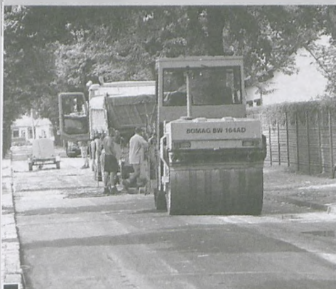
Na odcinku 11 Listopada od pętli autobusowej do skrzyżowania z ul. Traugutta wymieniono duże połacie nawierzchni fot. Hanna Siatka
