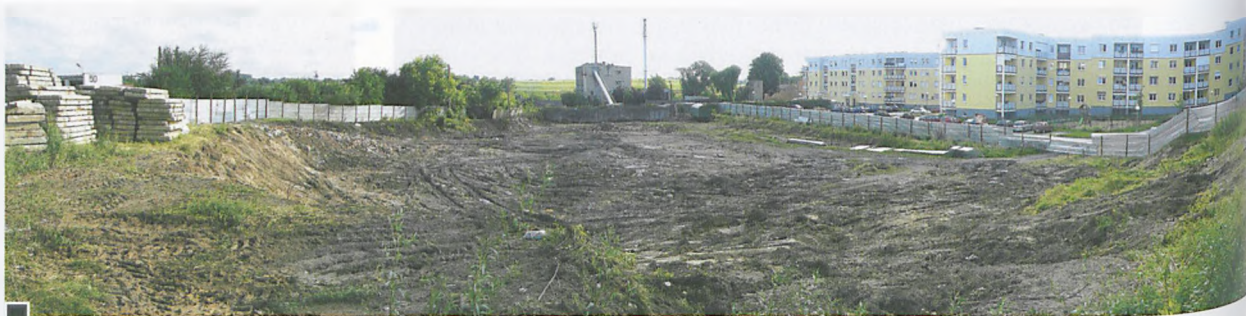
Panorama Doliny Józefata z placem budowy przyszłego bloku fot. Paweł Wolniewicz
