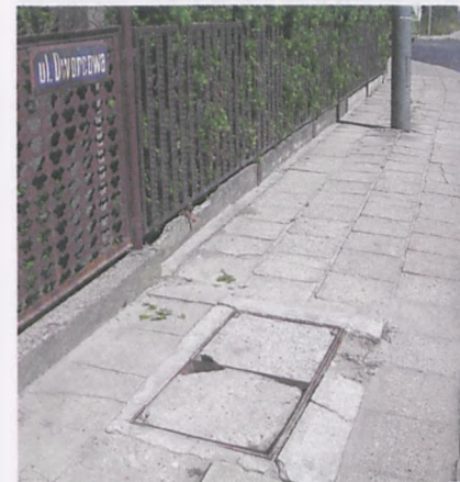
Na ul. Dworcowej, ale też na Okrzei znajduje się kilka uszkodzonych wstawek studzienek telekomunikacyjnych. Dziury są na tyle duże, że z łatwością może w nich utknąć zarówno obcas damskiego pantofelka jak i mała dziecięca stópka. fot. Karolina Szeląg
