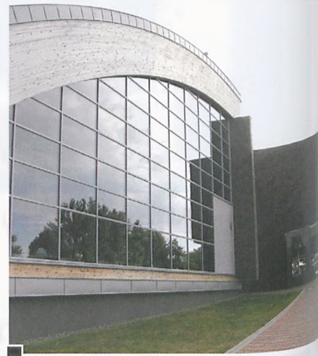
Imponujący gmach pływalni o drewnianej konstrukcji sklepień fot. Mateusz Pokrywka
