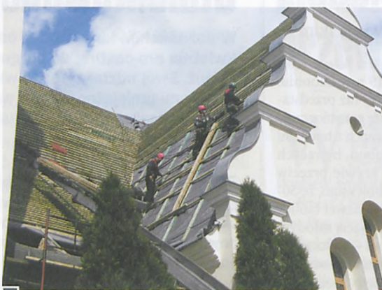
Montaż nowych łąt i specjalnej folii przed położeniem dachówki fot. Hanna Siatka
