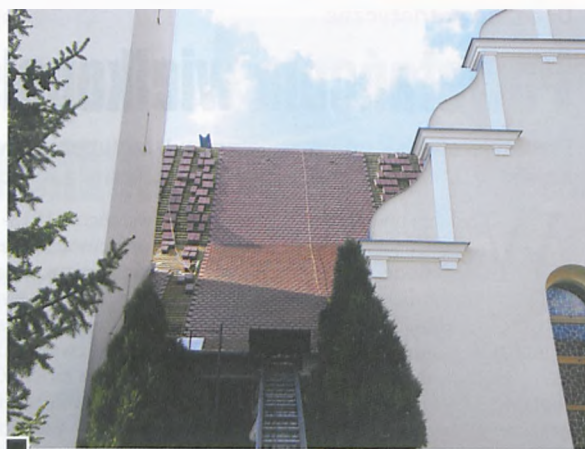
Układanie karpiówki od wschodniej strony kościoła fot. Hanna Siatka
