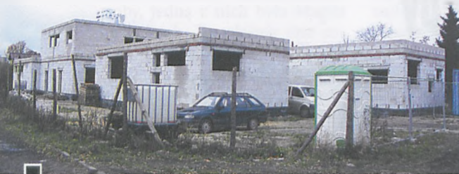
Plac budowy nowej placówki oświatowej fot. Jagoda Siatka
