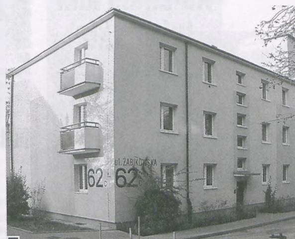
Pierwszy budynek SM w Luboniu przy ul. Żabikowskiej 62 C z widocznym kominem nieczynnej kotłowni fot. Jan Błaszczak
