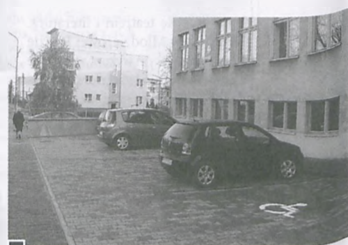
W ostatnim numerze pisaliśmy o rozpoczęciu prac związanych z budową jakże potrzebnego parkingu przy SP 3. Ku zadowoleniu zmotoryzowanych w pierwszych dniach listopada parking oddano do użytku. Posiada 7 miejsc, w tym jedno dla inwalidy fot. Paweł Wolniewicz
