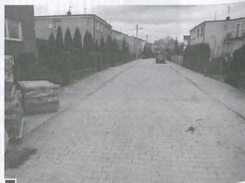
Podczas trwania prac na ul. Strumykowej fot. Mateusz Pokrywka
