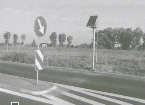
Nowa bateria słoneczna i znak oświetlony światłem mrugającym w nocy fot. Jan Błaszczak
