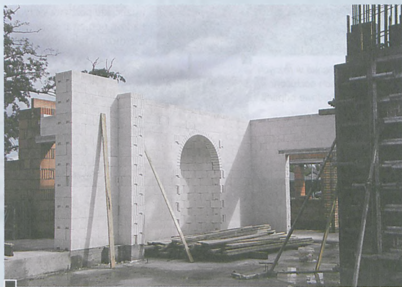
Ściana przednia nawy wschodniej wykończona niszą fot. Hanna Siatka
