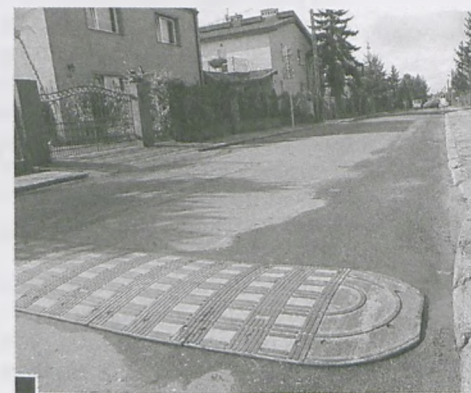
Próg zwalniający zainstalowany na ul. Kwiatowej fot. Piotr P. Ruszkowski
