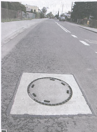
Nowocześnie i miejmy nadzieję poprawnie osadzony wąż studzienki kanalizacyjnej fot. Piotr P. Ruskowski
