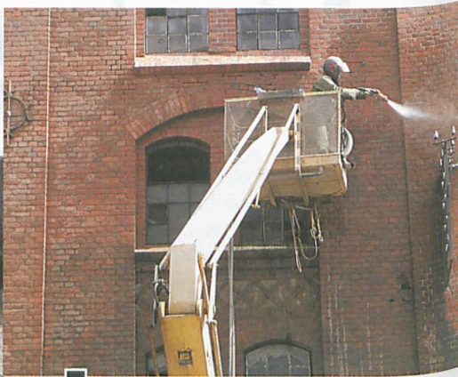
■ Czyszczenie odbywa się z kosza na wysięgniku samochodowym. Operator w odzieży ochronnej dyszą kieruje strumień wody i piasku systematycznie na poszczególne fragmenty ściany fot. Piotr P. Ruzkowski
