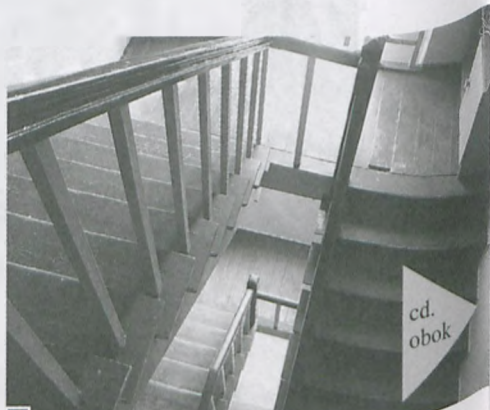
Drewniana klatka schodowa przy Tuwima 7 fot. Paweł Wolniewicz
