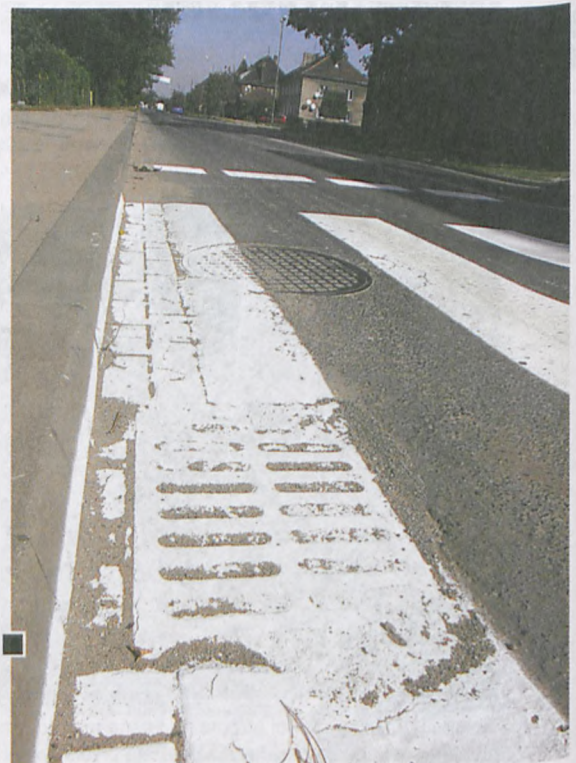
Zapchany i zamalowany gulik na ul. Armii Poznań fot. Piotr P. Ruszkowski
