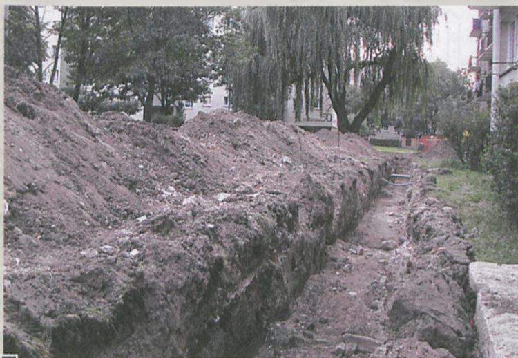
Wykopy w Luboniance fot. Mateusz Pokrywka
