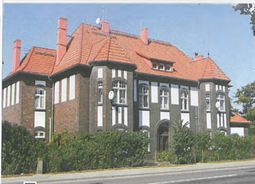
■ Pięknie prezentujący się w słońcu budynek po odrestaurowaniu przy ul. Armii Poznań 64
