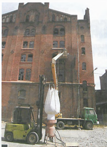
■ Na pierwszym planie specjalne urządzenie dozujące piasek do renowacji murów fot. Piotr P. Ruzkowski
