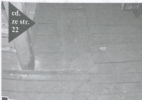
cd. ze str. 22 Drewniana podłoga i konstrukcja strychu na Mickiewicza 2. Widać też ślady zmuszającego drewna fot. Paweł Wolniewicz
