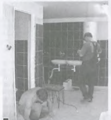
Remont szatni w SP 1 fot. Maria Radoła
