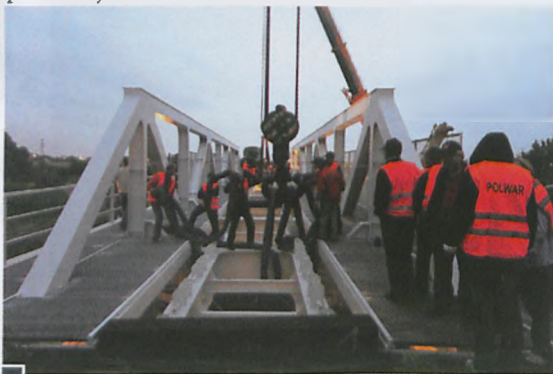
Nowy wiadukt już na swoim miejscu. Moment odczepiania haków dźwigu fot. Paweł Jankowiak
