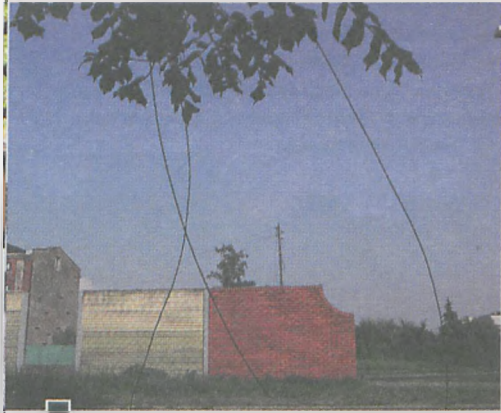
Niebezpieczne przewody pod napięciem zwisające z drzew. W oddali widzimy słup, z którego się zerwały fot. Mateusz Pokrywka
