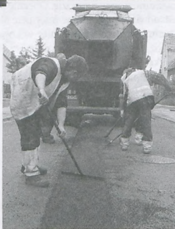
Trwają remonty nawierzchni asfaltowych ulic. Na zdjęciach frezowanie i asfaltowanie na ul. Wojska Polskiego fot. Mateusz Pokrywka
