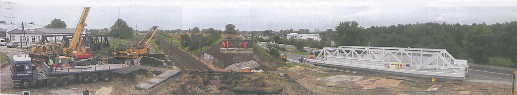
Miejsce akcji zamiany wiaduktów kolejowych. W środku dziura po zdemontowanym wiadukcie nad trakcją Poznań – Wrocław. Z lewej – stuletni, wysłużony wiadukt i demontujące go dźwigi. Z prawej – nowe przęśło na pętli autobusów L2 i L3 przy ul. Armii Poznań fot. Katarzyna Frąckowiak
