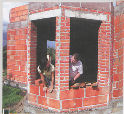
Państwo Patejowie na swojej budowie
