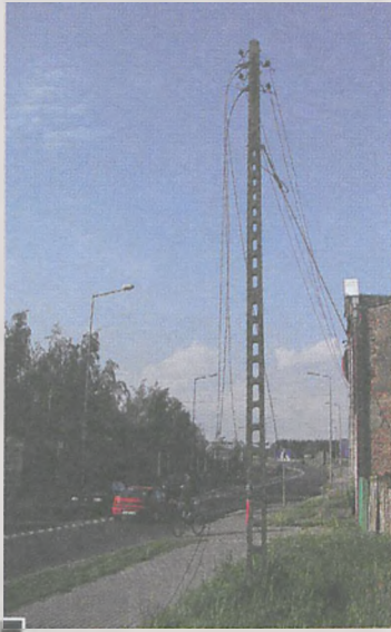
Kable zwisające ze słupa energetycznego fot. Mateusz Pokrywka
