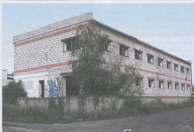
Ponury gmach nieczynnej fabryki wewnątrz tętni kolorami fot. Hanna Siatka
