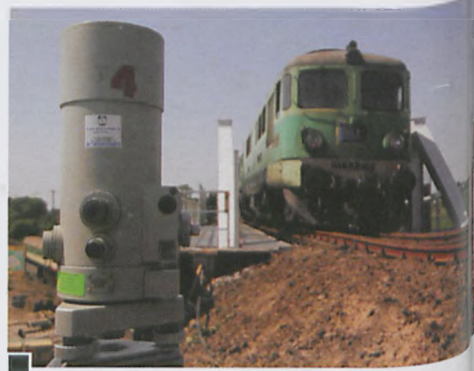
Próby obciążeniowe nowej konstrukcji prowadzone w sobotę 4 lipca. Na torach nowego wiaduktu najcięższy skład kolejowy. Z lewej urządzenie optyczne mierzące stopień ugięcia konstrukcji fot. Przemysław Maćkowiak
