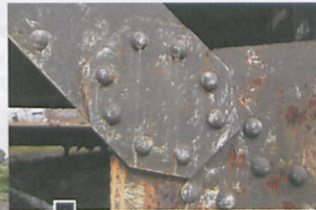
Fragment nitowanej konstrukcji starego przęśła fot. Przemysław Maćkowiak
