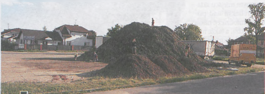
Plac przy ul. Targowej wykorzystywany jako składowisko materiałów sypkich wykorzystywanych przy budowie kanalizacji w ul. Fabrycznej i jako górką do zabaw dziecięcych
