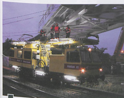
Montaż sieci trakcyjnej pod nowym przęśłem nad ranem w niedzielę 28 czerwca fot. Przemysław Maćkowiak
