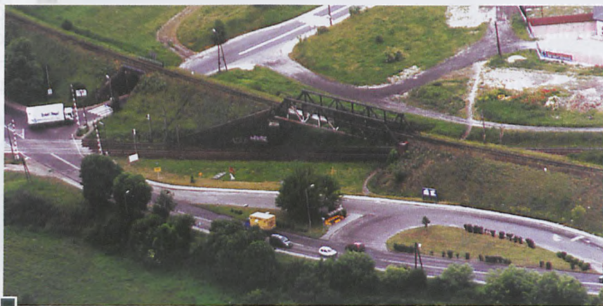
Zdjęcie lotnicze z 2004 r. kratownicowego wiaduktu kolejowego w Lasku (części obecnego Lubonia). U dołu ul. Armii Poznań z przejazdem kolejowym linii Poznań-Wrocław, na nasypie poprowadzona linia Wolsztyn-Poznań, z lewej ceglany wiadukt nad ul. Krętą fot. Przemysław Maćkowiak
