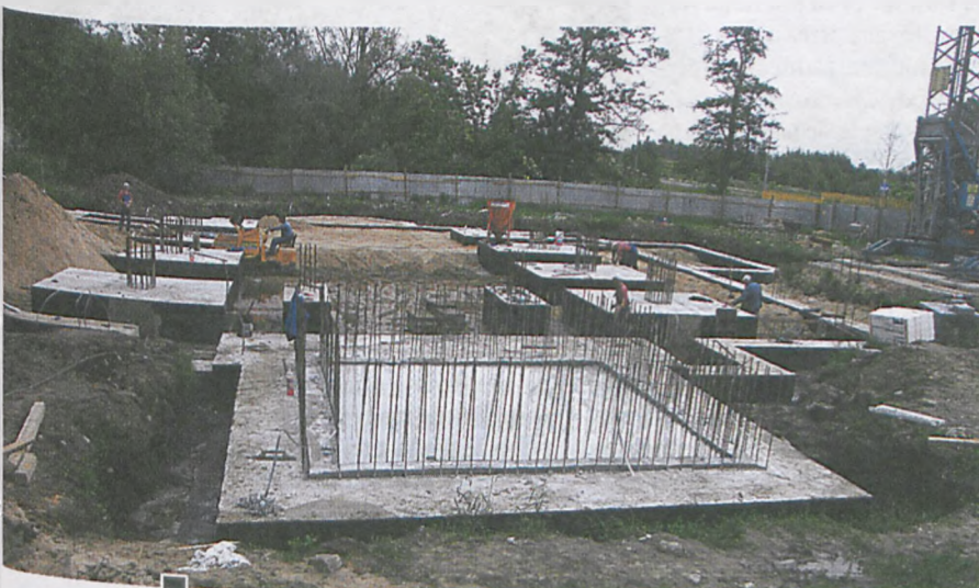
Specjalny fundament pod wieżę kościoła (od strony przyszłego wejścia przy ul. Źródlanej). Zalewanie tego fundamentu opóźniły deszcze fot. Piotr P. Ruskowski
