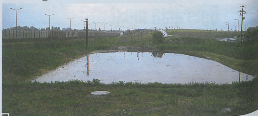
Po obfitych opadach pod koniec maja wypełniły się zbiorniki przyautostradowe. Na zdjęciu stan basenu przy ul. Unijnej fot. Jan Błaszczak
