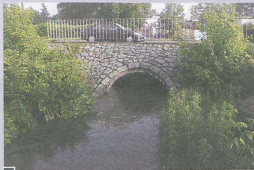
Przepust na ul. Powstańców Wlkp. fot. Piotr P. Ruszkowski
