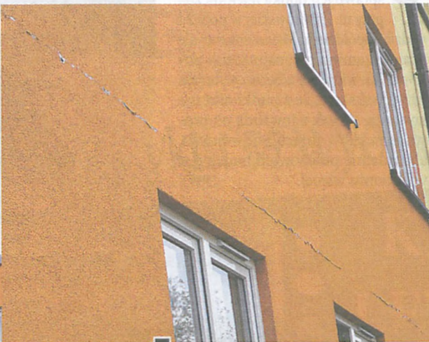
Wyraźne pęknięcia tynku pomiędzy kondygnacjami na budynku 3 B fot. Piotr P. Ruszkowski
