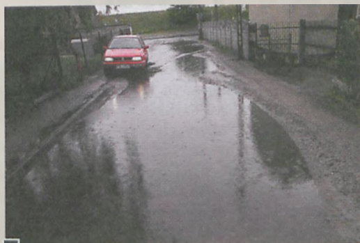
Ul. Rutkowskiego – w obawie przed zalaniem instalacji elektrycznej pojazdów, kierowcy jeżdżą chodnikami, niszcząc je i zanieczyszczając błotem fot. Piotr P. Ruszkowski
