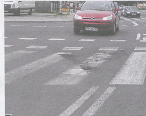
Skrzyżowanie Unijna, Kościuszki, Poniatowskiego – dziurawy asfalt po starej jezdni fot. Mateusz Pokrywka
