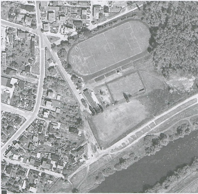
Luboński stadion przy ul. Rzecznej (na fragmencie ortofotomapy Lubonia) będzie przebudowany na potrzeby II ligi. Powstaną nowe trybuny, zadaszenie i kompleks socjalno-sportowy z trzygwiazdkowym hotelem i restauracją fot. Jerzy Domicz
