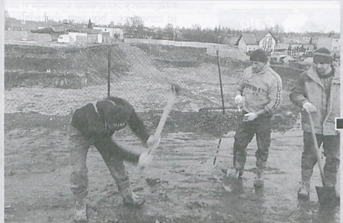
Robotnicy rozpoczynają prace przy przesuwaniu płotu fot. Mateusz Pokrywka
