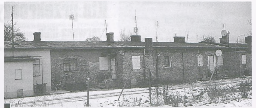
Z przeznaczonego do likwidacji budynku komunalnego przy ul. Kościuszki 39 wysiedlono większość lokatorów. Widać to po zamurowanych drzwiach i oknach. Część mieszkańców trafiła do nowych budynków przy ul. Źródlanej, inni do starszych lokali miejskich na terenie Lubonia fot. Jan Błaszczak
