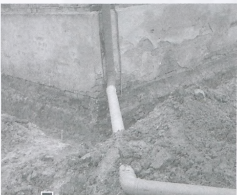
Odsłonięto fundamenty w celu ich konserwacji fot. Kamila Pruszk-Postuszny
