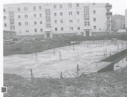
Fundamenty pod kolejny budynek SM w Luboniu fot. Jan Błaszczak
