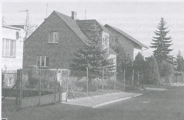
Remontowany budynek pogotowia znajduje się w ciągu zabudowy jednorodzinnej fot. Mateusz Pokrywka
